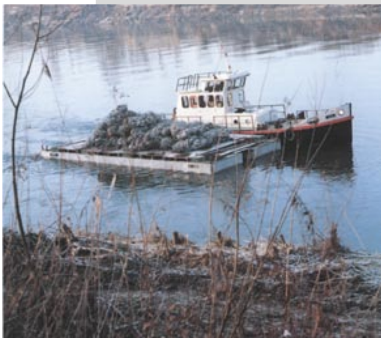
Prijevoz vrećastih gabiona pontonom s gradilišta na mjesto ugradnje
