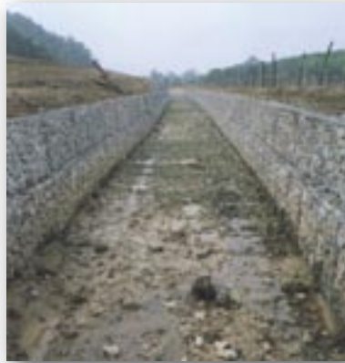
Primjer kanaliziranja vodenog toka gabionima
