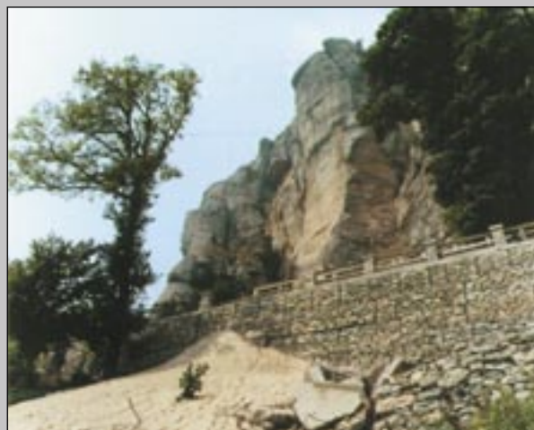
Izravni potporni zid ceste
