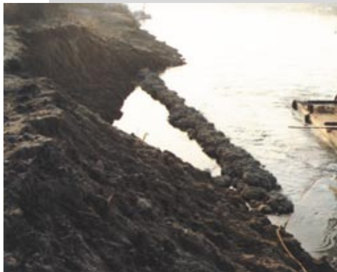
Radovi u koritu rijeke s jedne strane prije ispunjavanja nasipa u završnoj fazi
