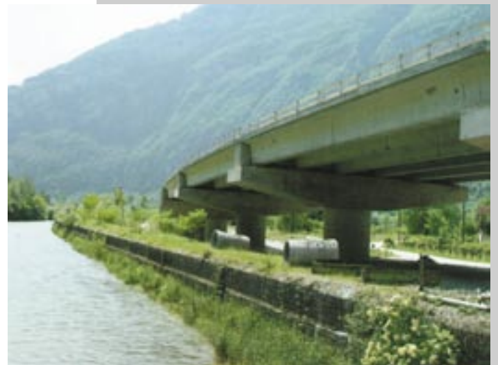
Gabioni postavljeni kao zaštita od erozije u blizini vijadukta na auto cesti
