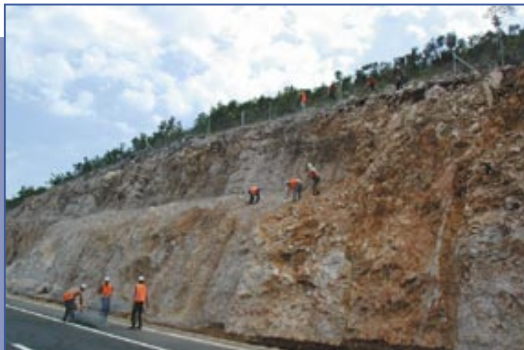
Primjer učvršćivanja zaštitnih mreža protiv odrona
