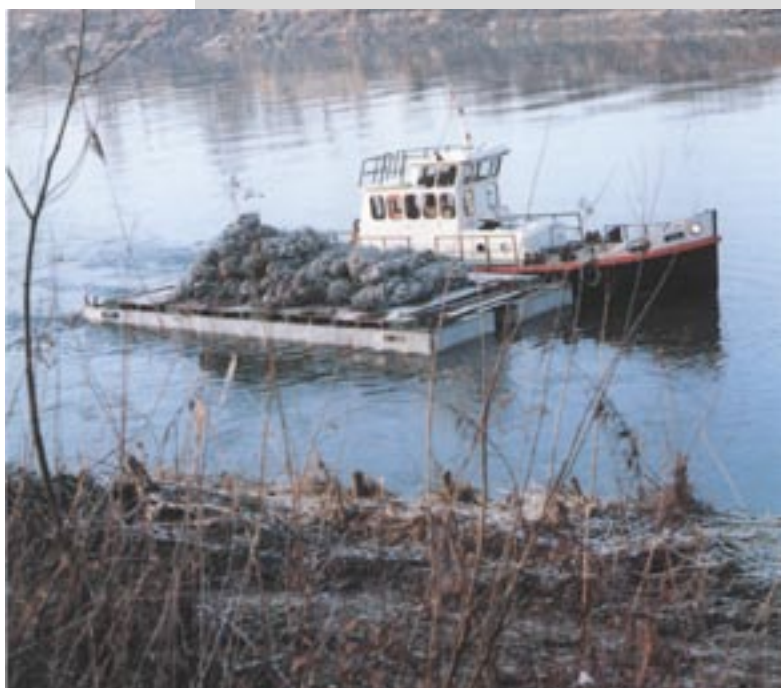
Prijevoz vrećastih gabiona pontonom s gradilišta na mjesto ugradnje
