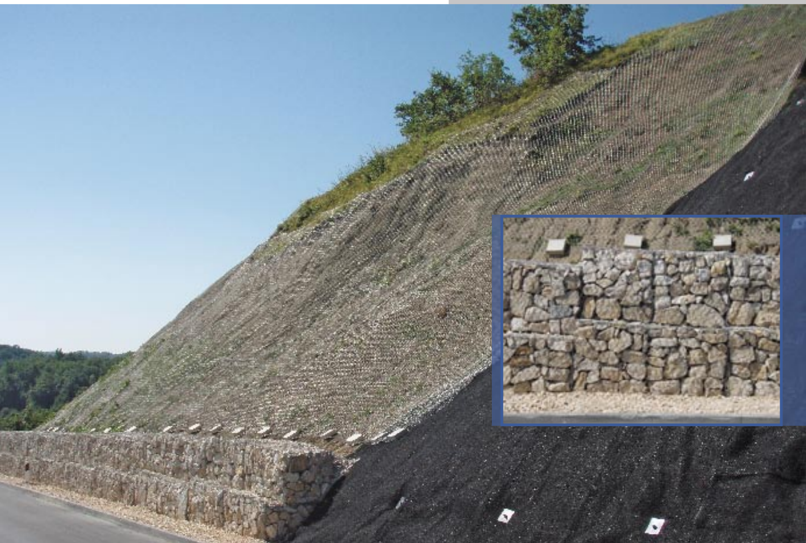
Gabionski zid za zaštitu pokosa i objekta na vrhu pokosa
