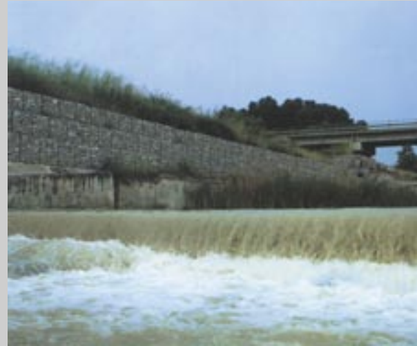
Primjer kanaliziranja vodenog toka gabionima
