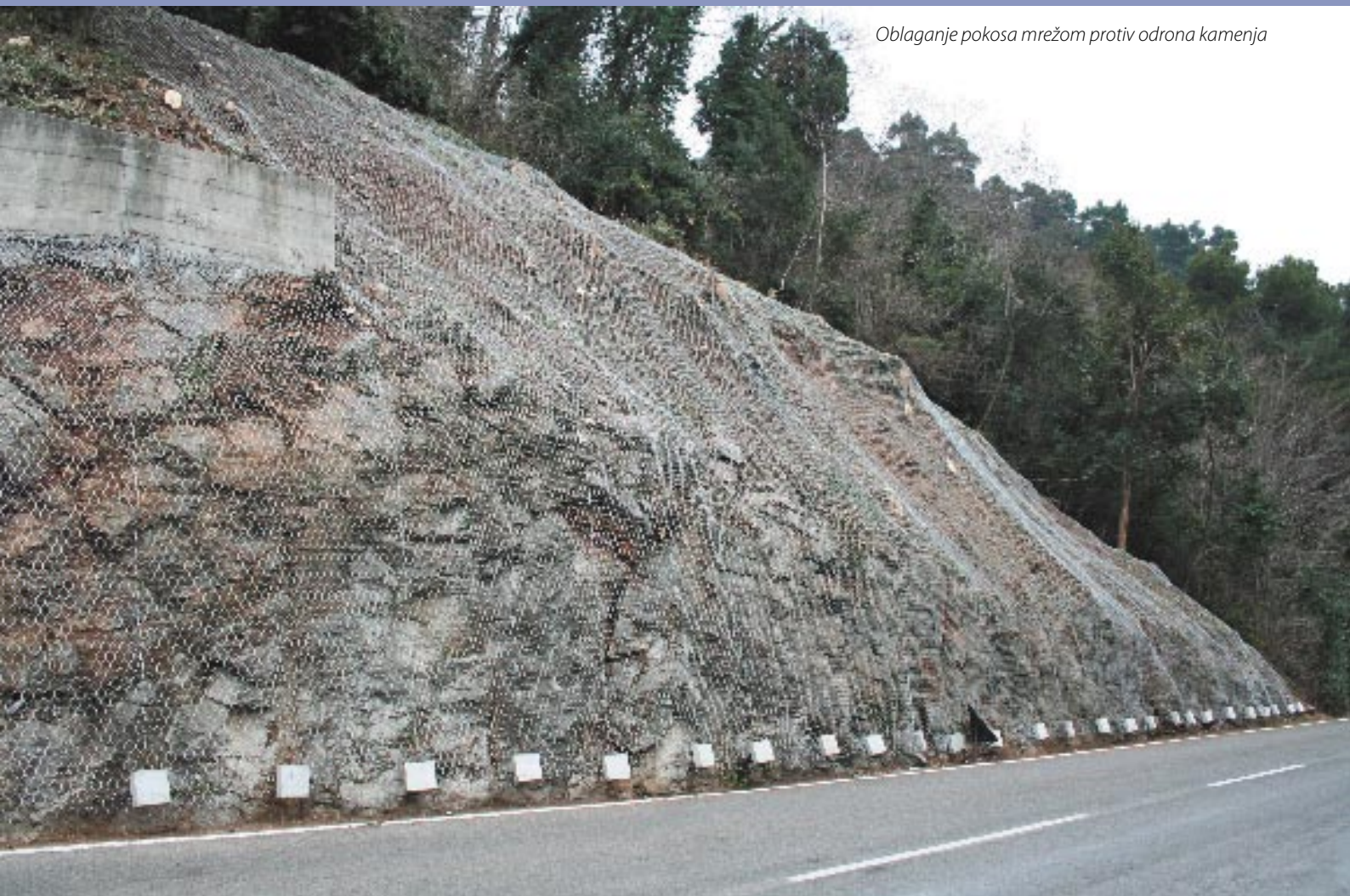
Primjer učvršćivanja zaštitnih mreža protiv odrona
