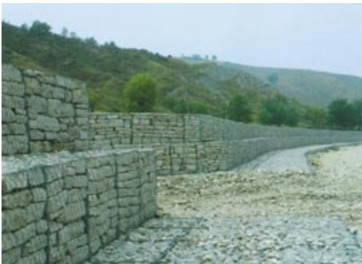
Primjer uzdužne strukture za učvršćenje obale rijeke na spoju sa priotokom
