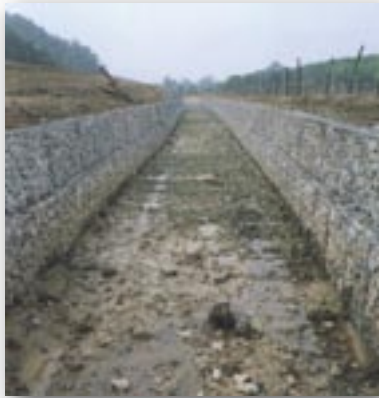
Primjer kanaliziranja vodenog toka gabionima
