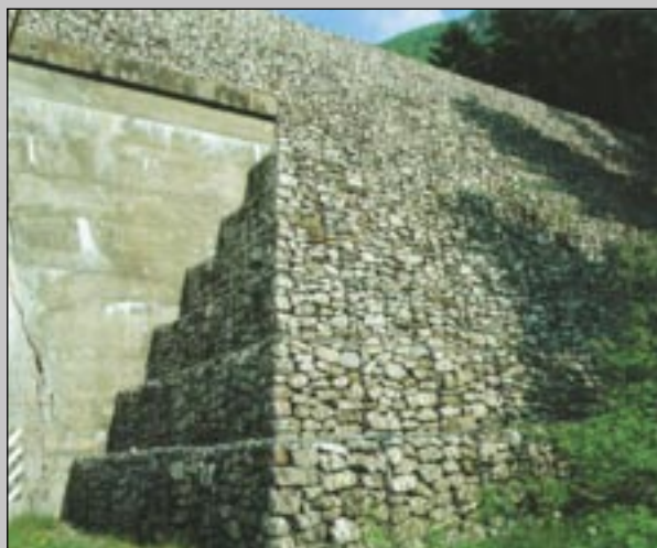
Gabionski zid za zaštitu pokosa i objekta na vrhu pokosa
