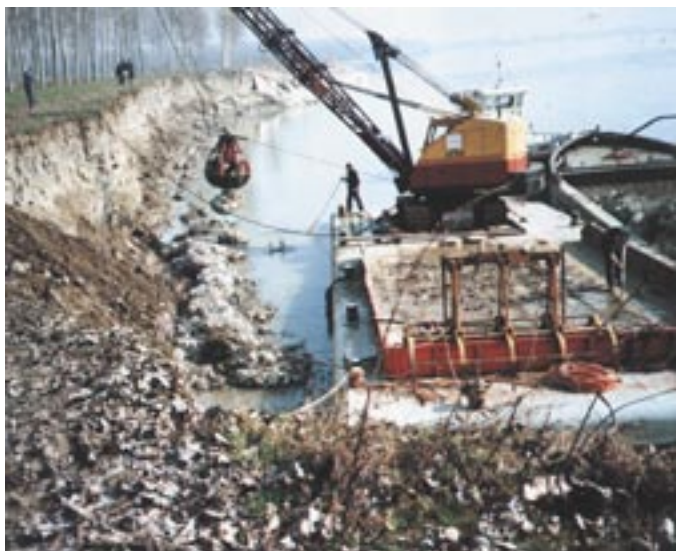
Postavljanje vrećastih gabiona
