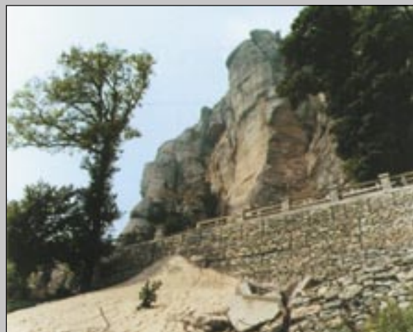
Izravni potporni zid ceste
