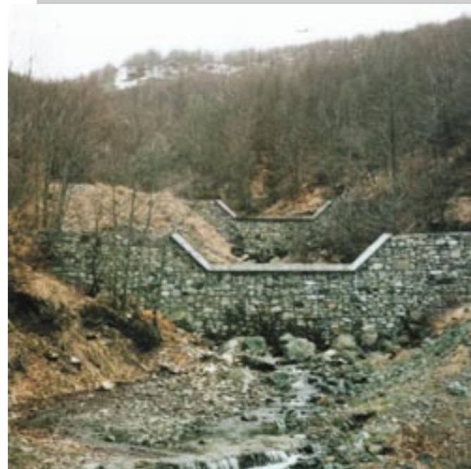
Primjer postavljanja brana. Obratite pozornost na pokrov u armiranom betonu koji štiti pletivo naprikazanom dijelu
